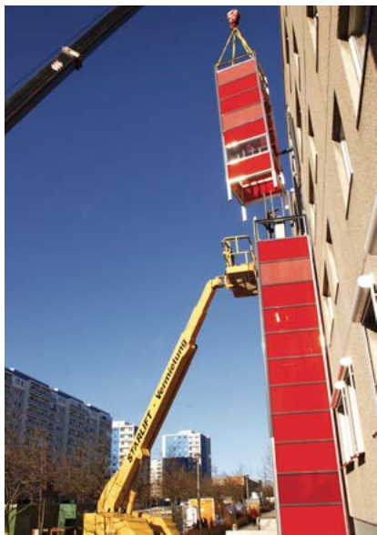
Установка лифта в пятиэтажном здании, Хеллерсдорф, Берлин
