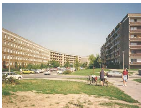
Состояние жилого фонда в районе Хеллерсдорф, Берлин в 1989 году и после первой волны модернизации в середине 1990-х гг.
